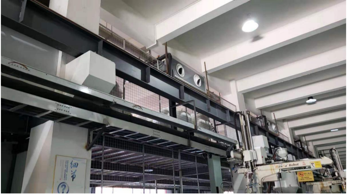
注塑车间废气收集
