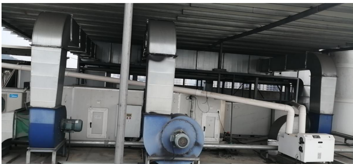
排气收集管道
